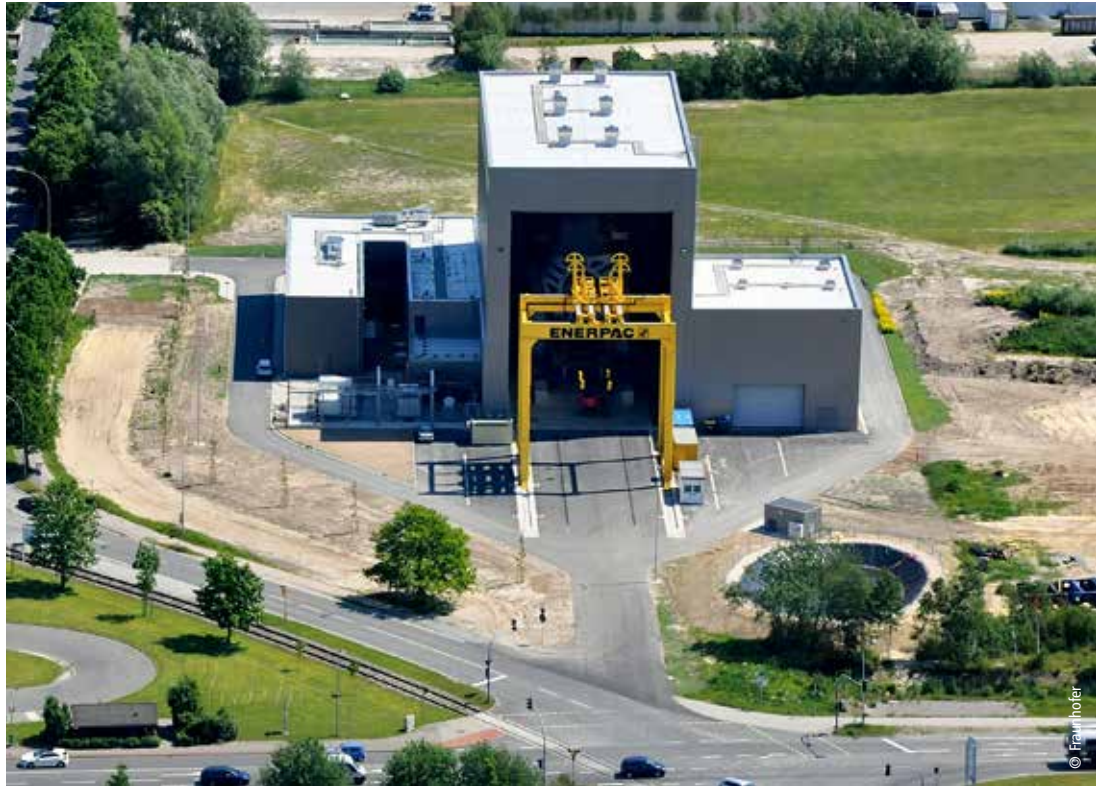
实际实验台以及液压和冷却系统位于测试中心综合大楼的大厅，大量的电气设备位于左侧那栋大楼里
