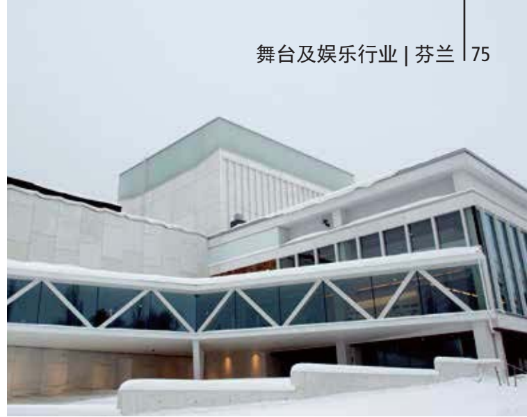
芬兰库奥皮奥城市剧院。建筑的新旧部分的通过从旧建筑部分的大堂沿着幕墙到新建筑部分的礼堂之间的一个桥段衔接，形成一个防护罩
