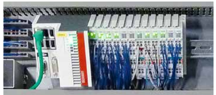
使用 CX5010 嵌入式控制器和 EtherCAT 端子模块实施了一套高性能的超紧凑型控制系统
