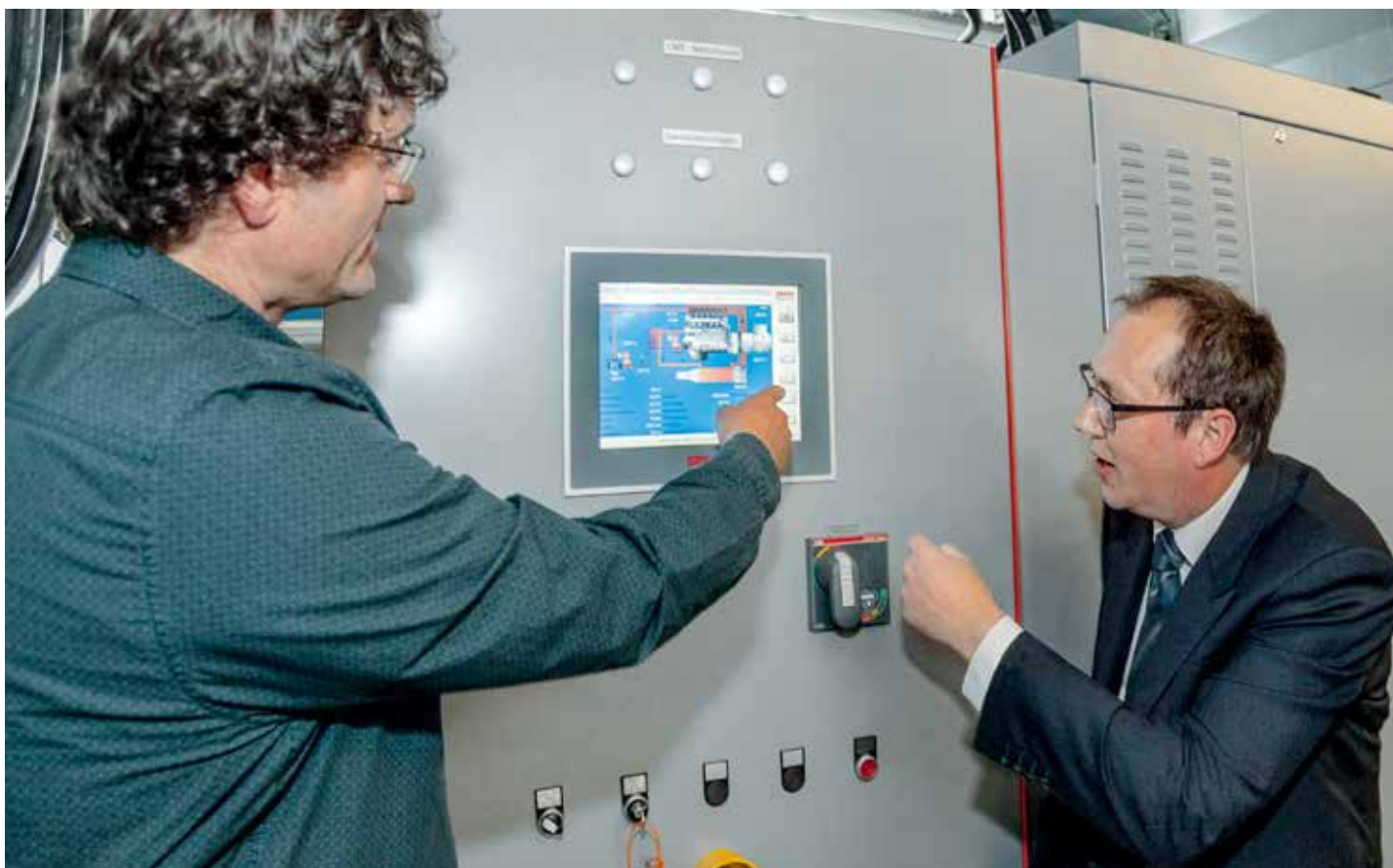
SOKRATHERM 总经理 Klaus Pollmeier (右) 和 Beckhoff 销售人员 Thomas Kaiser (左), 在热电联供系统试运行期间, 使用 CP6201 面板型 PC 作为中央控制单元
