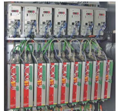
25 根电动伺服轴和 12 根液压伺服轴由 Beckhoff 伺服驱动系统 AX2003 控制
