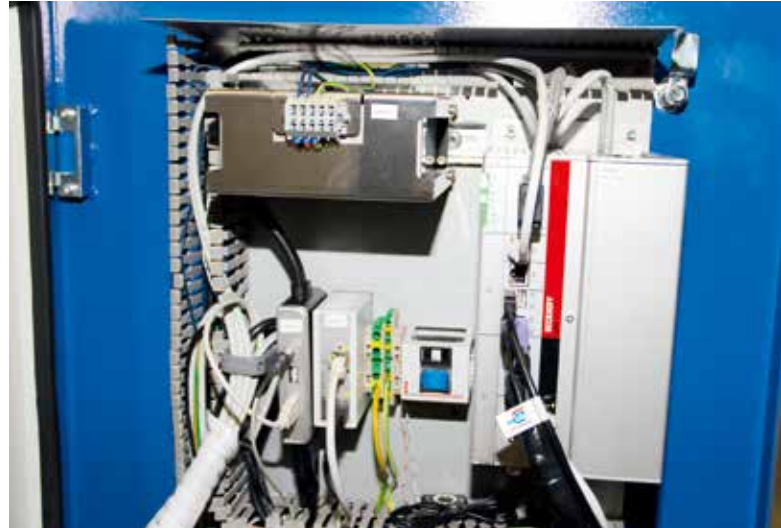
C6920 控制柜式工业 PC 采用 Intel®Celeron®1.9 GHz 双核处理器，为要求苛刻的圆弧插补功能提供充足的计算能力
