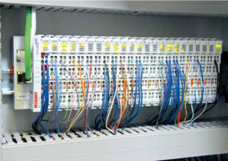
EtherCAT 耦合器 EK1100 将众多 EtherCAT 端子模块集成到控制系统中，如用于电阻传感器的 2 通道输入端子模块 EL3202 和增量编码器接口端子模块 EL5101
