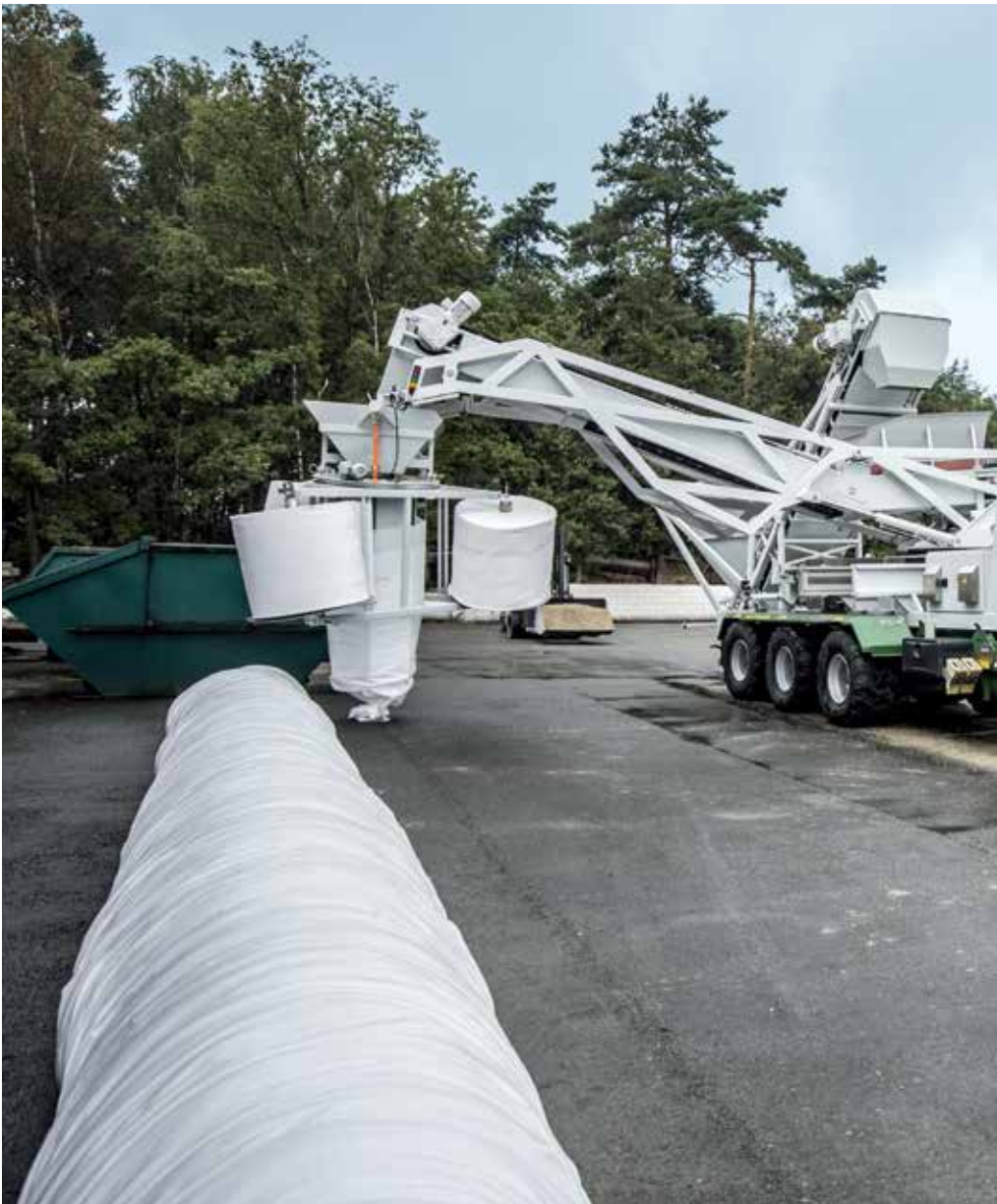
图为铺设第二根管道时的开始步骤。随后，第三根管道以金字塔形添加。这样，可以使用 Topomover3.5 快速制造一个具有相当规模的防护坝
