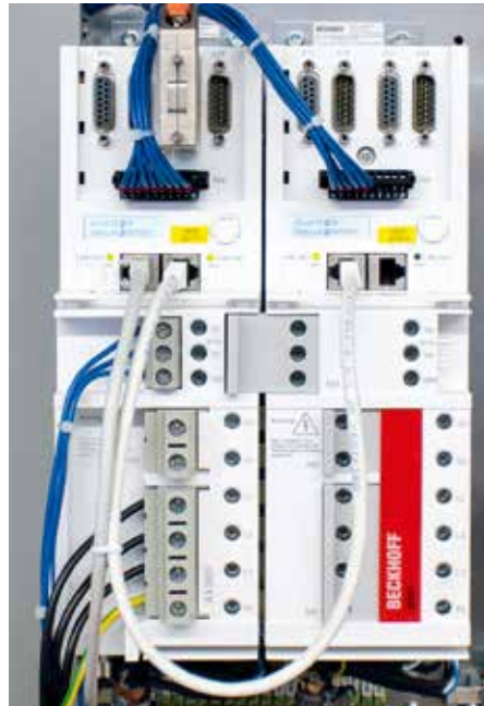
两套配备 TwinSAFE 选项卡 AX5805 的 AX5206 伺服驱动器控制 AM8000 OCT 伺服电机
