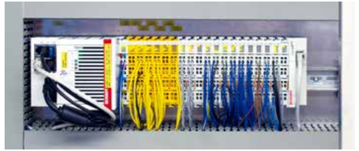
控制柜内部一瞥：倍福的 CX5140 嵌入式控制器通过 EtherCAT 和 TwinSAFE I/O 端子模块运行枕式包装机的包装工艺
