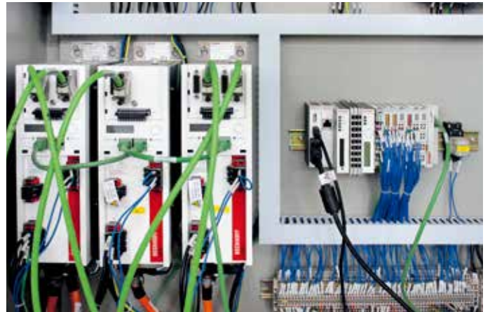
AX5000 系列 EtherCAT 伺服驱动器用于精确定位电机轴位置通过 AX5000 驱动器的探针功能进行实时捕捉
