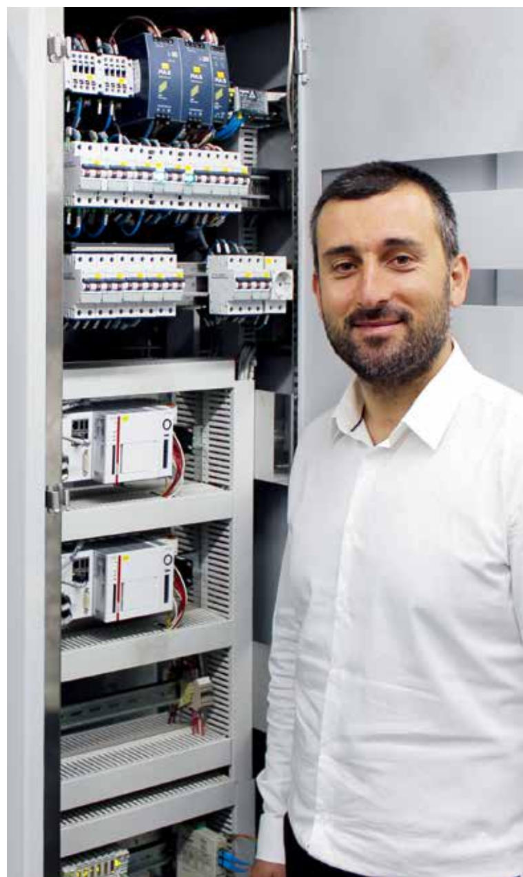
本项目中共使用了 84 台倍福 CX2020-0121 嵌入式控制器作为 42 座车站的网关控制系统
