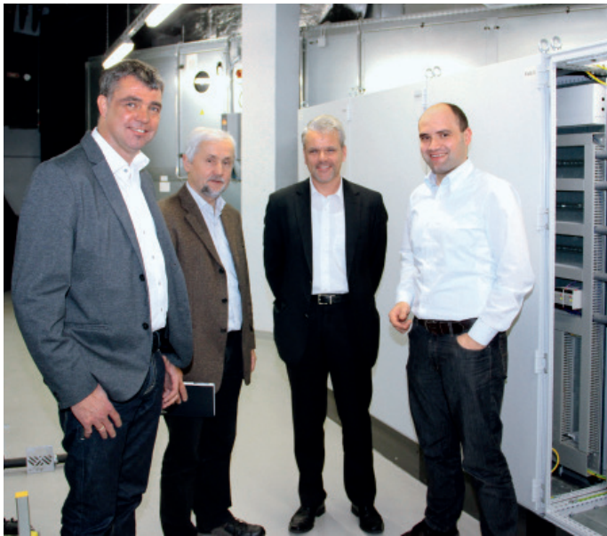
从左至右: Herrmann 公司的楼宇自动化团队负责人 Michael Falkenstein, 弗劳恩霍夫 IAO 的大楼管理人员 Heinz Kühner, 来自 Beckhoff 德国巴林根办事处的 Oliver Heilig 和弗劳恩霍夫 IAO 的大楼主管站在 ZVE 地下室 HVAC 设备的控制柜前
