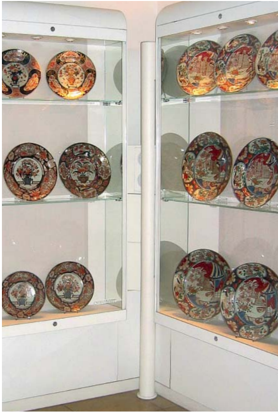
在紧急情况下广播疏散语音指示的扬声器被安装在展柜后面看不见的地方
