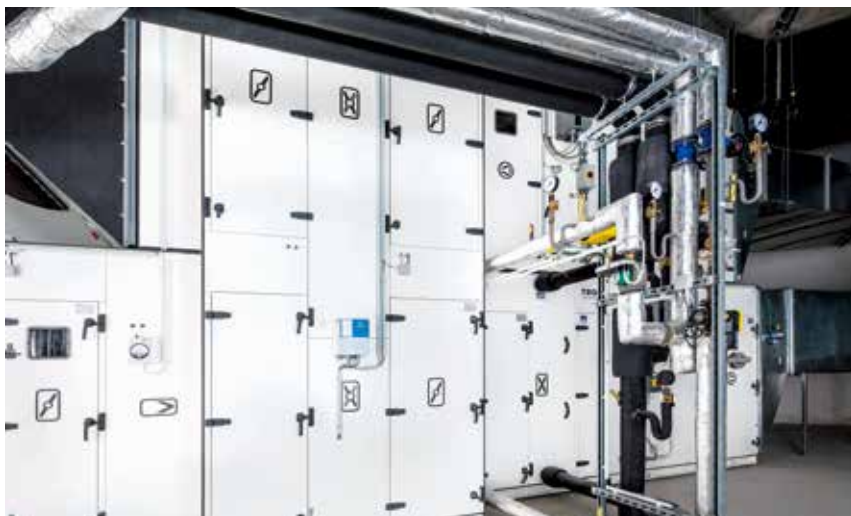
9 个 X-Cube，配置为送风和吸气机组，具有高效的叉流板式热交换器，确保 Buchholz Galerie 在任何时候都保持最完美的状态
