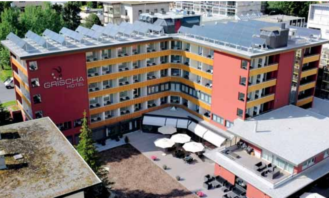
Grischa四星级酒店基于两家现有酒店建筑的框架进行建设。“Caprice”和“Terminus”这两座建筑通过新辅楼连接。
