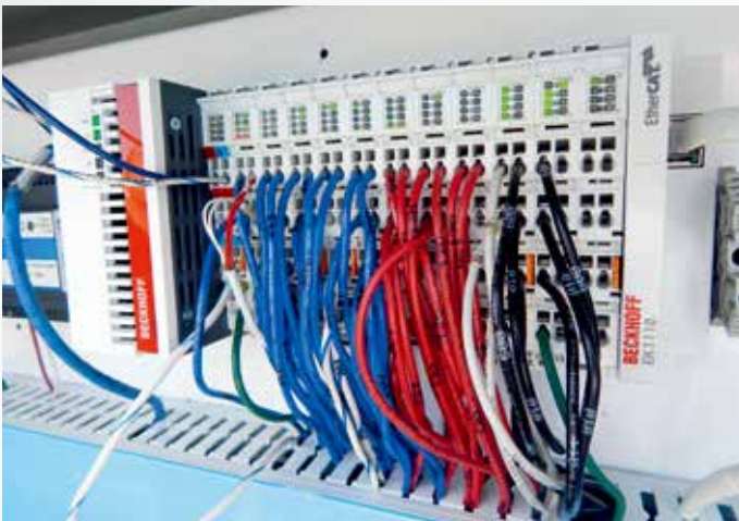
CX5020 嵌入式控制器用作风力发电机组的中央控制器。它监测馈电情况、进行必要的风速和位置调整、记录数据并发送故障消息
