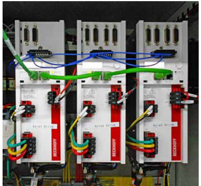
AX5112、AX5203 和 AX5206 伺服驱动器负责精确控制转台的偏航、俯仰、横滚三种角度的变位方式
