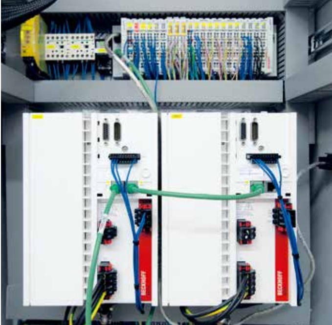
上面是一个装有两台 AX51xx 系列伺服驱动器和 3 个 EL7201 伺服端子模块的控制柜
