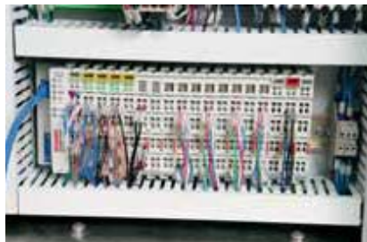
步进电机能够直接接入总线端子模块系统, 无需使用额外的驱动器
