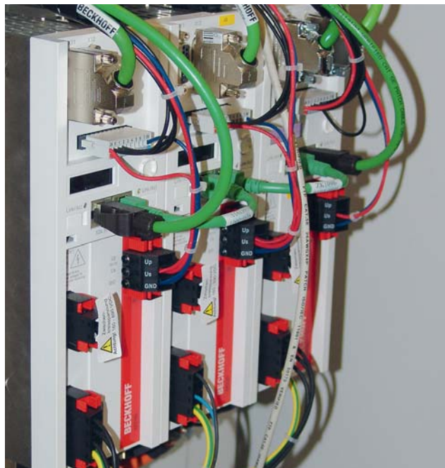
装有 Beckhoff AX5000 系列 EtherCAT 伺服驱动器的控制柜
